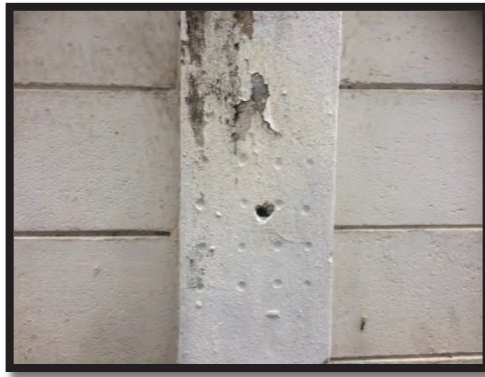
รูปที่ 12 แสดงตัวอย่างความเสียหายของผิวคอนกรีตอันเนื่องมาจากการกระทบของค้อน
